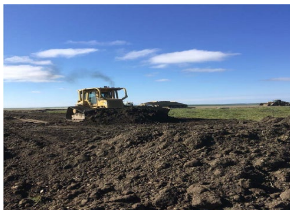
Opérateur de machinerie lourde sur un bulldozer pendant la construction du sentier des lacs Husky.
