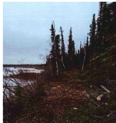
Construction en cours sur le sentier d'accès aux collectivités à pied ou en VTT à Whatì
