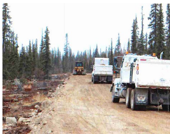
Bulldozer et camions à bennes au cours de la construction de 2 020 de la route d'accès de Wekweèti.
