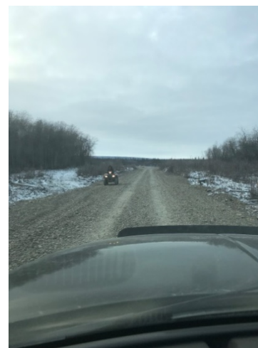
Route d'accès à la rampe de mise à l'eau de Happy's Landing après l'application du granulat.
