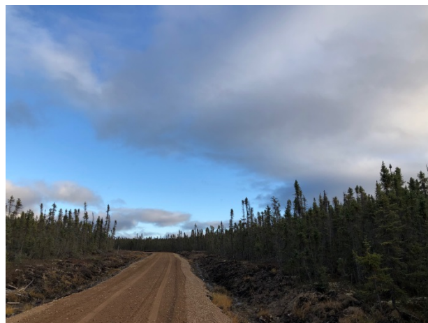
Nouvelle section construite sur la route d'accès au lac Austin à Łutsel'ke.
