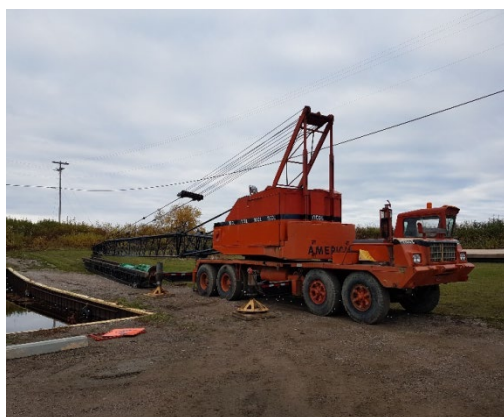
Longue grue et pilon pendant la construction à la marina de Porritt Landing.
