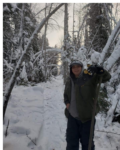
Construction des sentiers d'accès avec tronçonneuses à Nahanni Butte.
