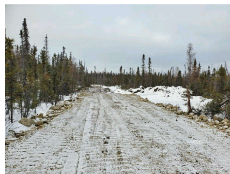
Route d'accès à l'étang Duck à Gamètì après la fin de la construction en 2020-2021.
